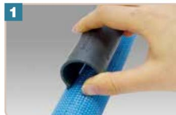
防火キットのスリット部の突起を、配管側面に引っ掛けます。
